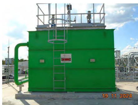
ระบบปรับสภาพน้ำทิ้ง (Neutralization Tank)
